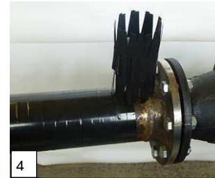
4 Äußere Klebestreifen der Schutzeinlage lösen und Schutzeinlage abwickeln.
