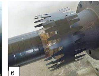
6 Schutzeinlage um die Flanschverbindung herumziehen und überlappend mit dem Klebestreifen fixieren.
