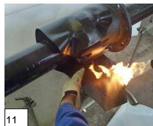
11 Manschette um die Flanschverbindung herumziehen, das Ende hochklappen und von innen erwärmen.
