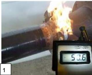
1 Bei vorhandener Restfeuchte die Rohranschlüsse des Flansches mit Hilfe einer Propangasflamme trocknen und Rohr auf 50°C vorheizen
