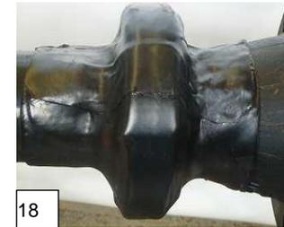
Der Schrumpfvorgang ist beendet, wenn die Manschette überall gleichmäßig eng anliegt und der Thermoindikator nicht mehr fühlbar ist.
