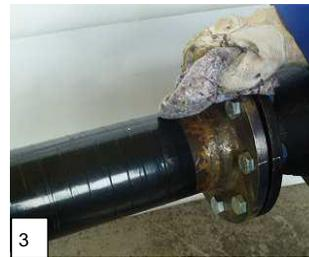
3 Erforderlichenfalls mit sauberem Lappen und Lösemittel Reste der Korrosionsschutzfarbe abbürsten.
