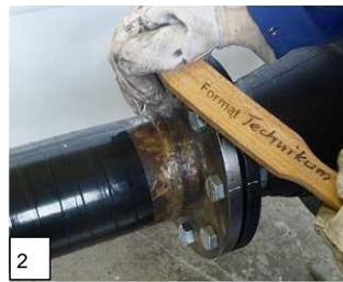
2 Verunreinigungen und Korrosionsschutzfarbe abbürsten.
