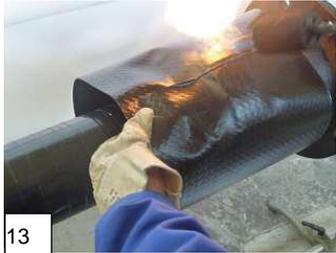
Folie von oben erwärmen bis der Thermoindikator nicht mehr fühlbar ist.
